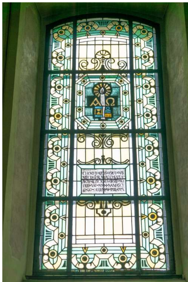
Okno nawy Kościoła i klatki schodowej.
